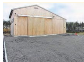
Die Salzhalle steht bereits. Davor entsteht der neue Bauhof für 1,8 Millionen Euro. Bild: bk
